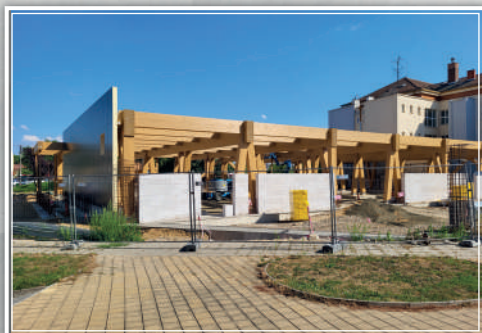
Modernizace Hustopeče – srpen
