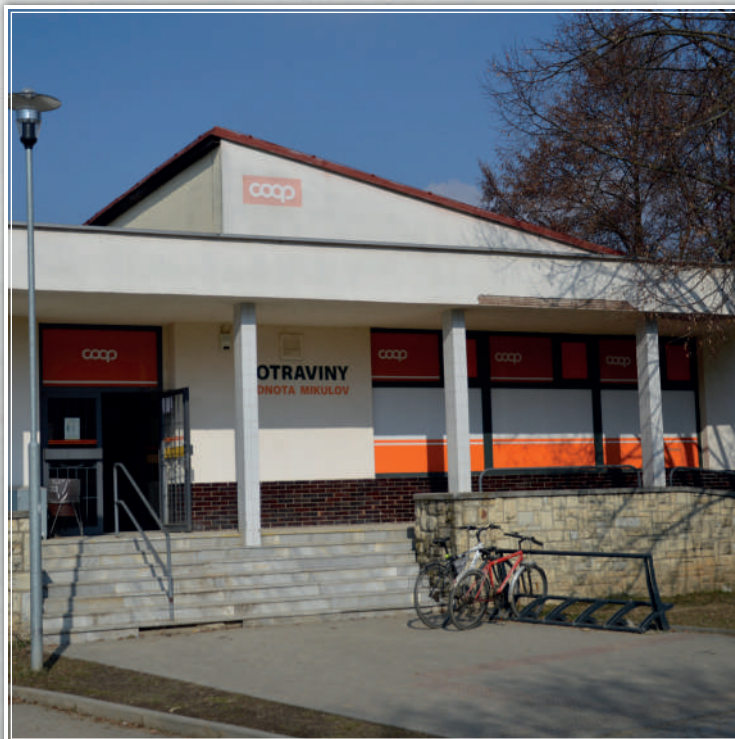
Boleradice před rekonstrukcí
