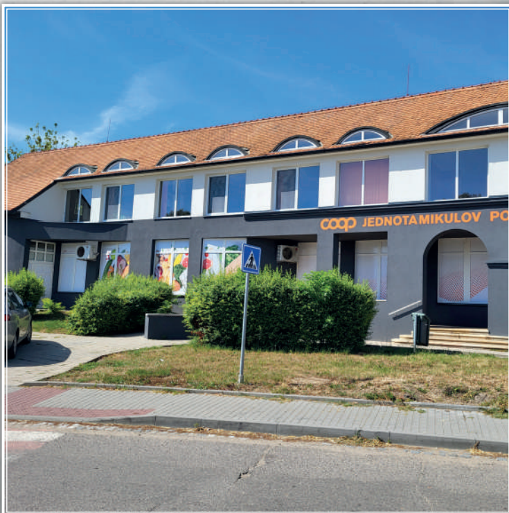
Drnholec po rekonstrukci
