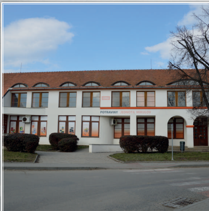
Drnholec před rekonstrukcí
