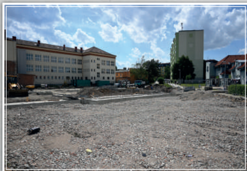
Modernizace Hustopeče – červen
